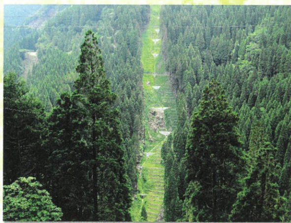
【平成27年度写真コンクール最優秀賞】 「山あいに見える山腹工」宮本満則(熊本県熊本市)
