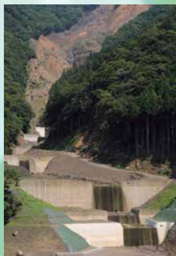
【平成30年度写真 コンクール最優秀賞】 「災害から守る治山事業」 岡本 一高 (京都府 八幡市)
