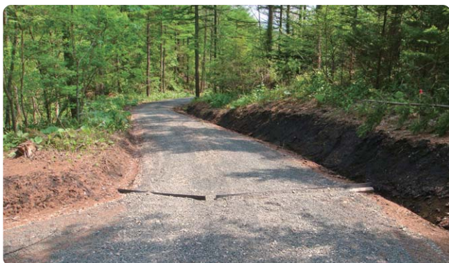
屋根型路盤に排水処理用の二次製品(鶴居村)
